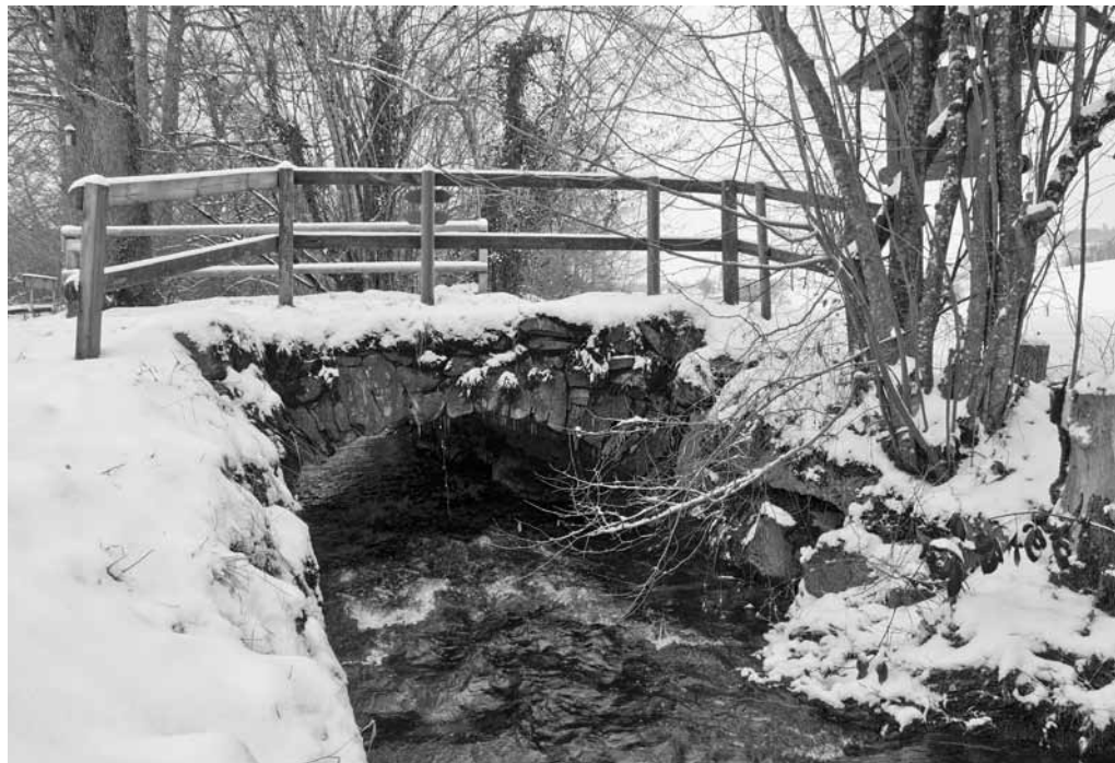
Man beachte auf der rechten Seite die Infotafel zur historischen Brücke.
